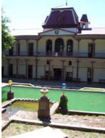
Ilustración 16. Parque y casona Arrieta
